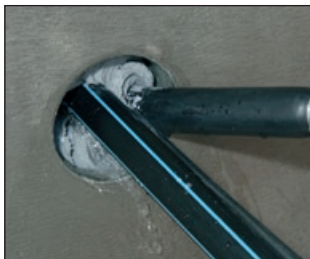
Füllen des Ringspalt
