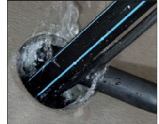
Einspritzen von Flex 2000
