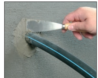
Verspachteln mit Schnellzement
